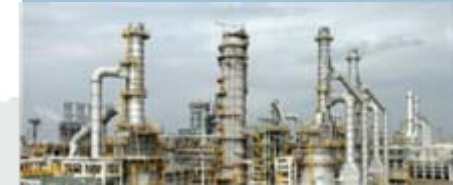
Petrochemische Anlage "Reliance Industries" (Indien)
