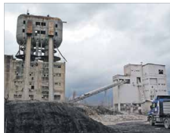
Die stillgelegte Fabrik „Zukunft“ in Presevo. Die blühende Industrie von einst liegt heute brach.
